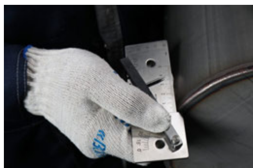
Приемо-сдаточные испытания: визуальный контроль качества сварного соединения
