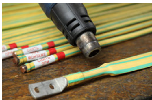
Опрессовка кабельного наконечника и усадка термоусадочной трубки медного отвода
